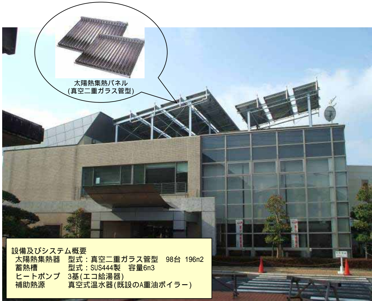
川崎町老人福祉センター(太陽熱エネルギー利用給湯システム施設)
